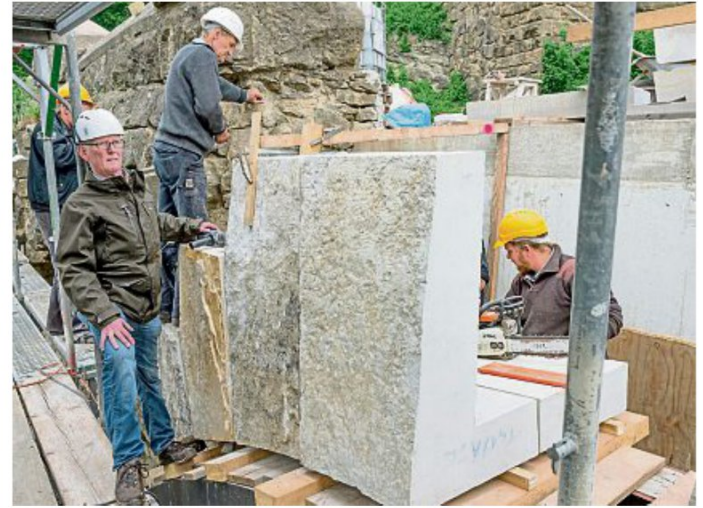
Bernd Dirks, Inhaber des gleichnamigen Steinmetzbetriebes in Billerbeck, erhielt den Auftrag für die Steinmetzarbeiten bei der Renovierung des Denkmals an der Porta Westfalica. Foto: Dirks GmbH
